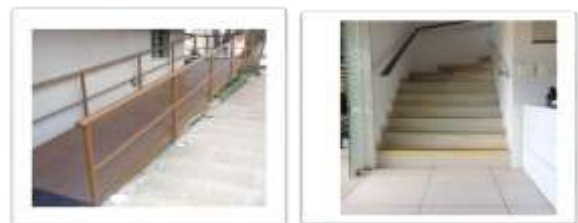
Figura 2: Ambiente de acesso com espaço reduzido na instituição de longa permanência em Caruaru-PE [16].
